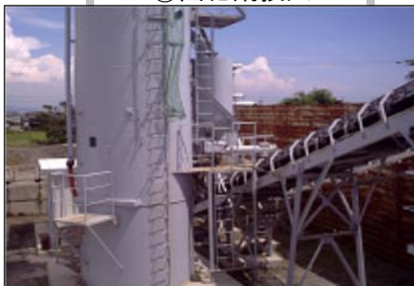
⑤固化剤投入
