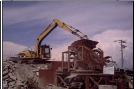
⑨破碎プラント投入
