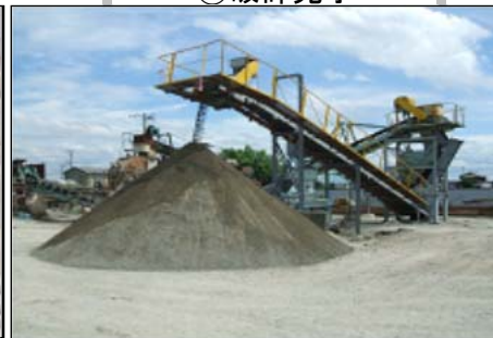
⑪破碎完了
